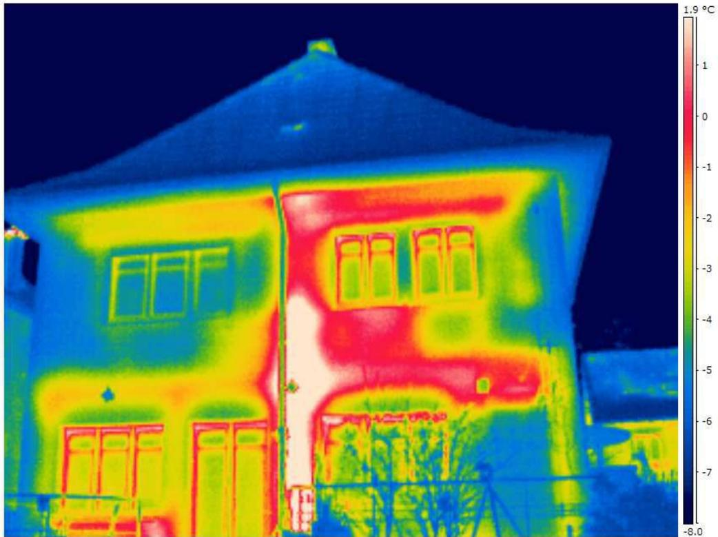
Die selbe Haus-Fassade wie im Bild zuvor. Hier ist der obere und untere Messpunkt an der Temperaturskala rechts vom Bild verstellt worden. Dadurch können die Schwachstellen deutlicher in den Vordergrund gestellt werden.
